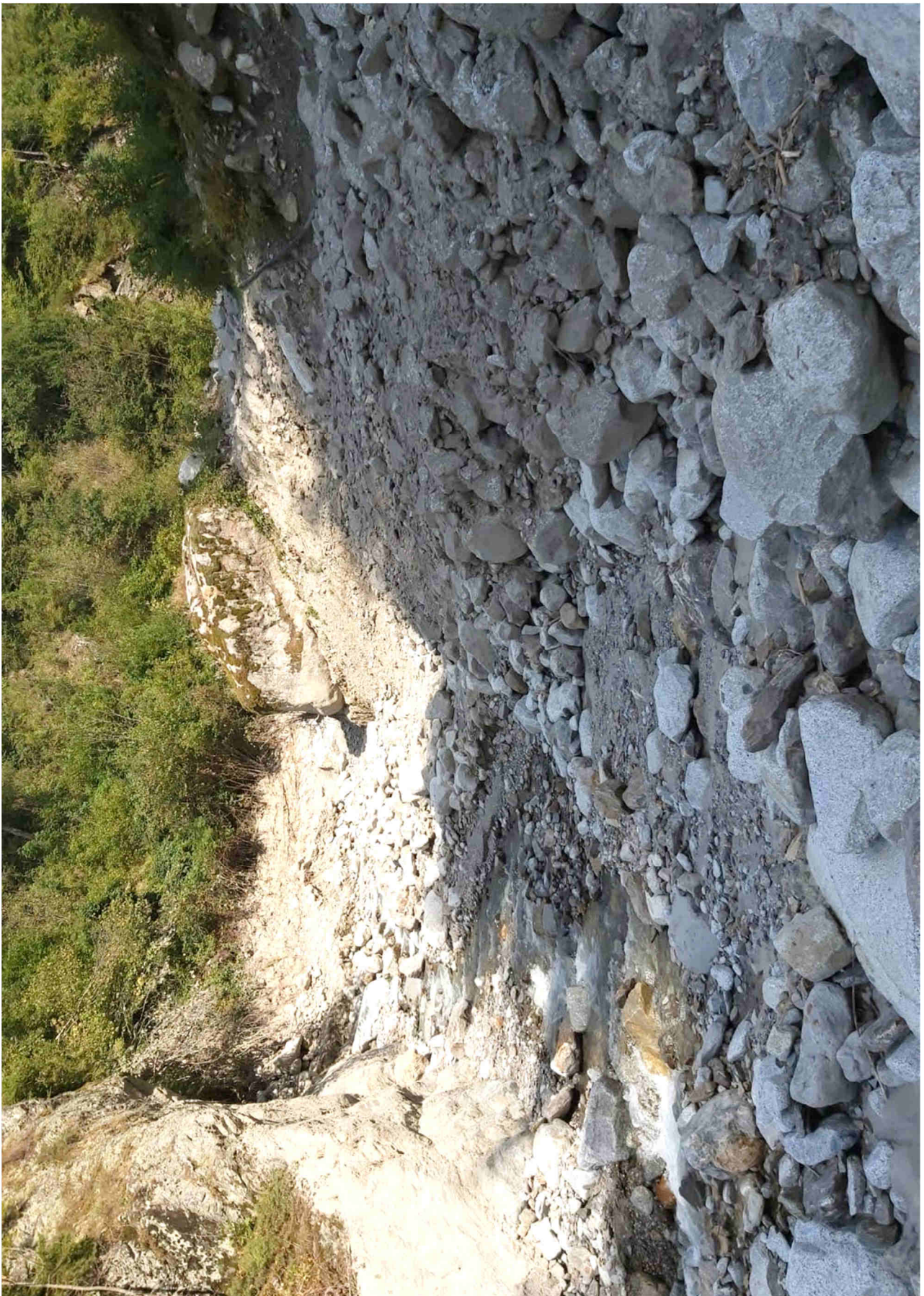
Vista da valle della sezione selettiva da restringere ulteriormente. Si intravede la sponda sinistra con l'inizio del suo degrado
