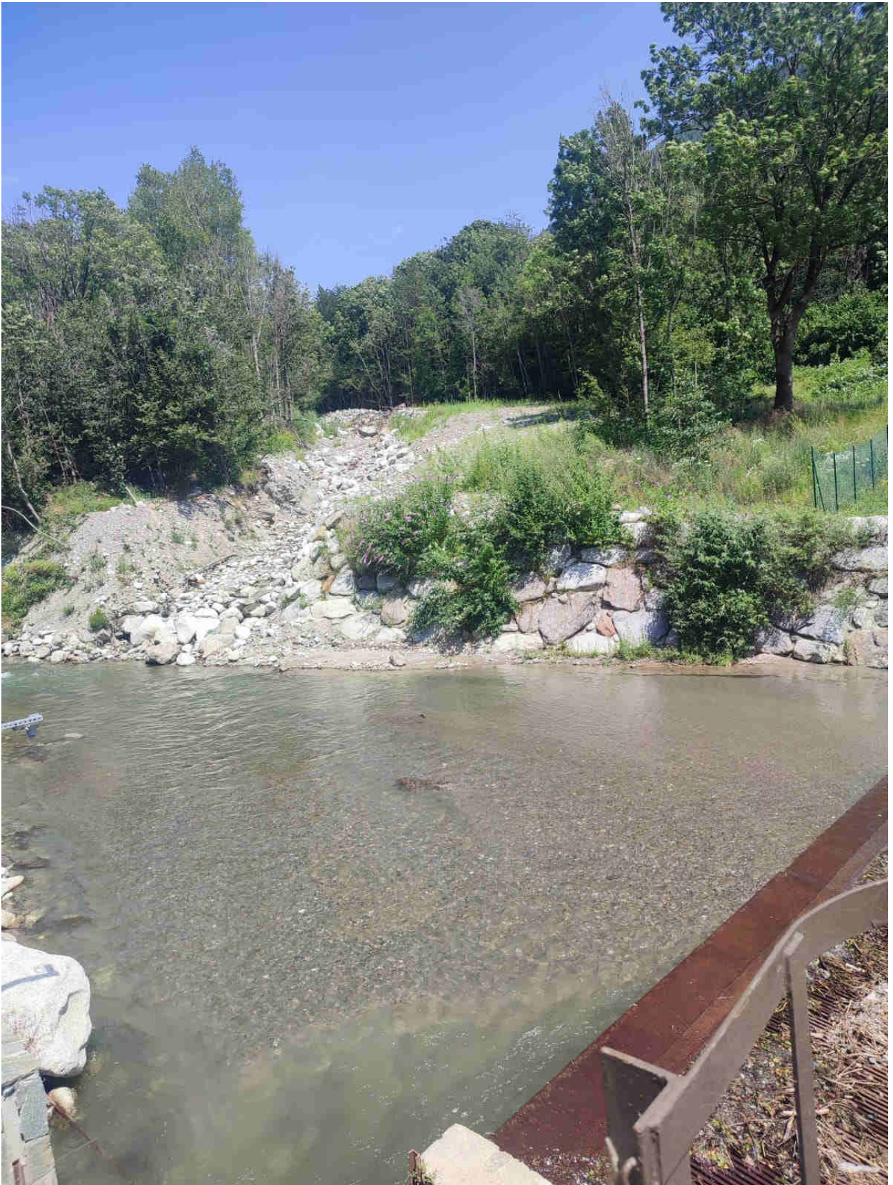
Sbocco del t. Val Finale e tratto di fiume Oglio verso monte, dove verrà formata la vasca di deposito.
