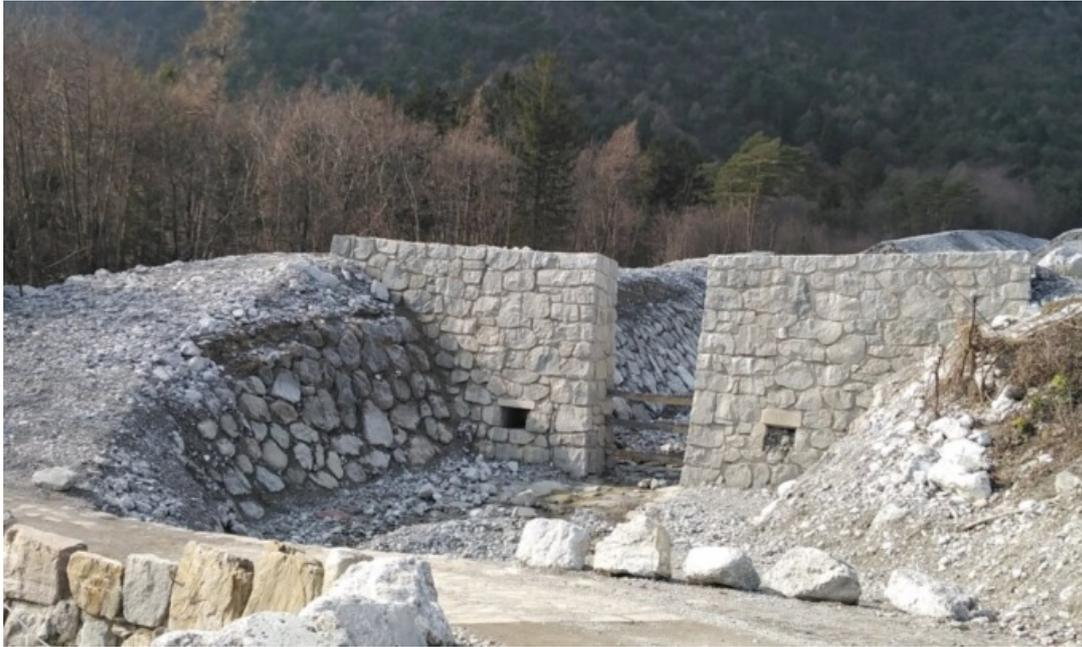
*Figura 15: Briglia a fessura "tipo". In questo caso la verifica idraulica consiste nella verifica che le portate di progetto possano transitare attraverso la fessura centrale, che può avere diverse forme. (Torrente Ble di Ono S. Pietro)*
