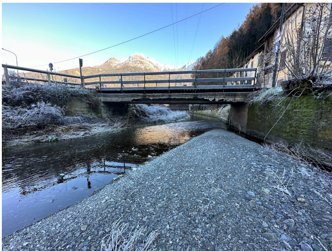
Figura 1 Ponte esistente (visto verso valle) da demolire
