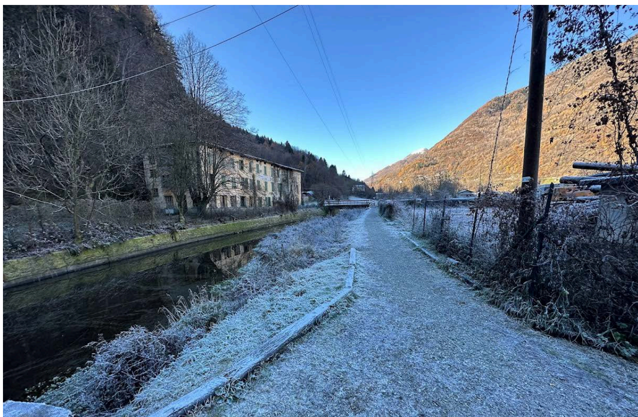
Figura 8 Vista dell'alveo (tratto dalla passerella all'impalcato esistente)
