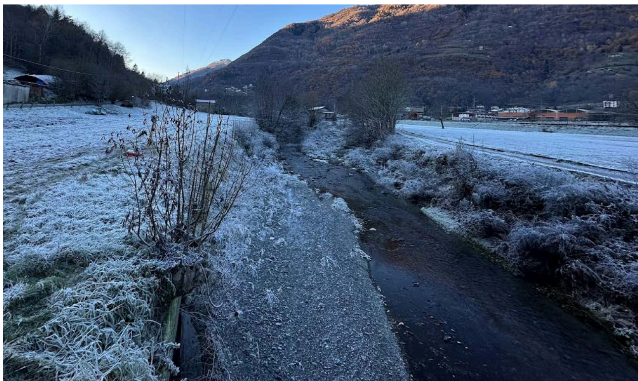
Figura 7 Vista dell'alveo (verso monte) nel quale verranno realizzate le scogliere
