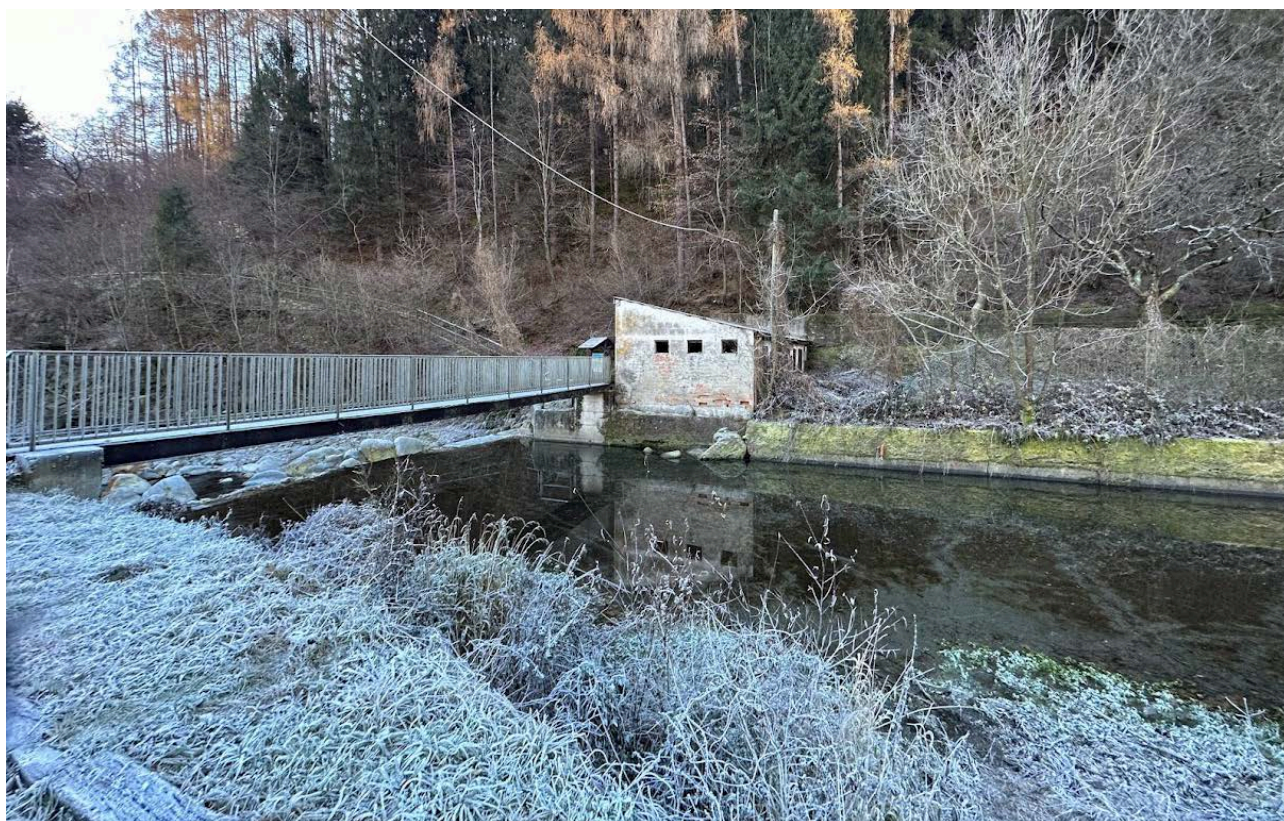
Figura 9 Vista della passerella pedonale in acciaio
