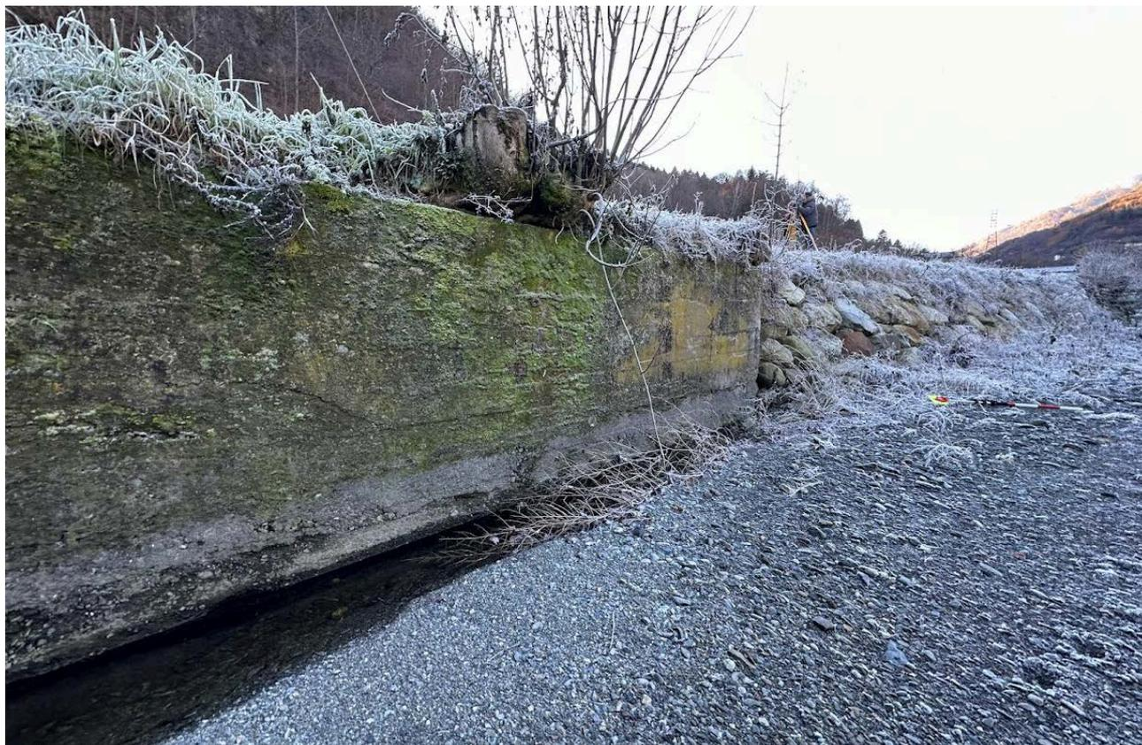
*Figura 3 - muro d'argine in calcestruzzo da demolire*
