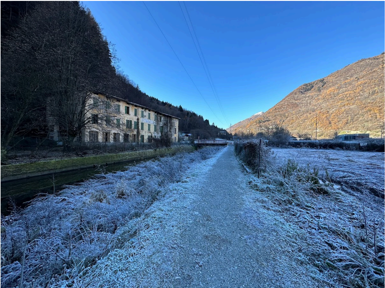
Figura 1 – fabbricato esistente ravvicinato alla sponda destra dell'alveo
