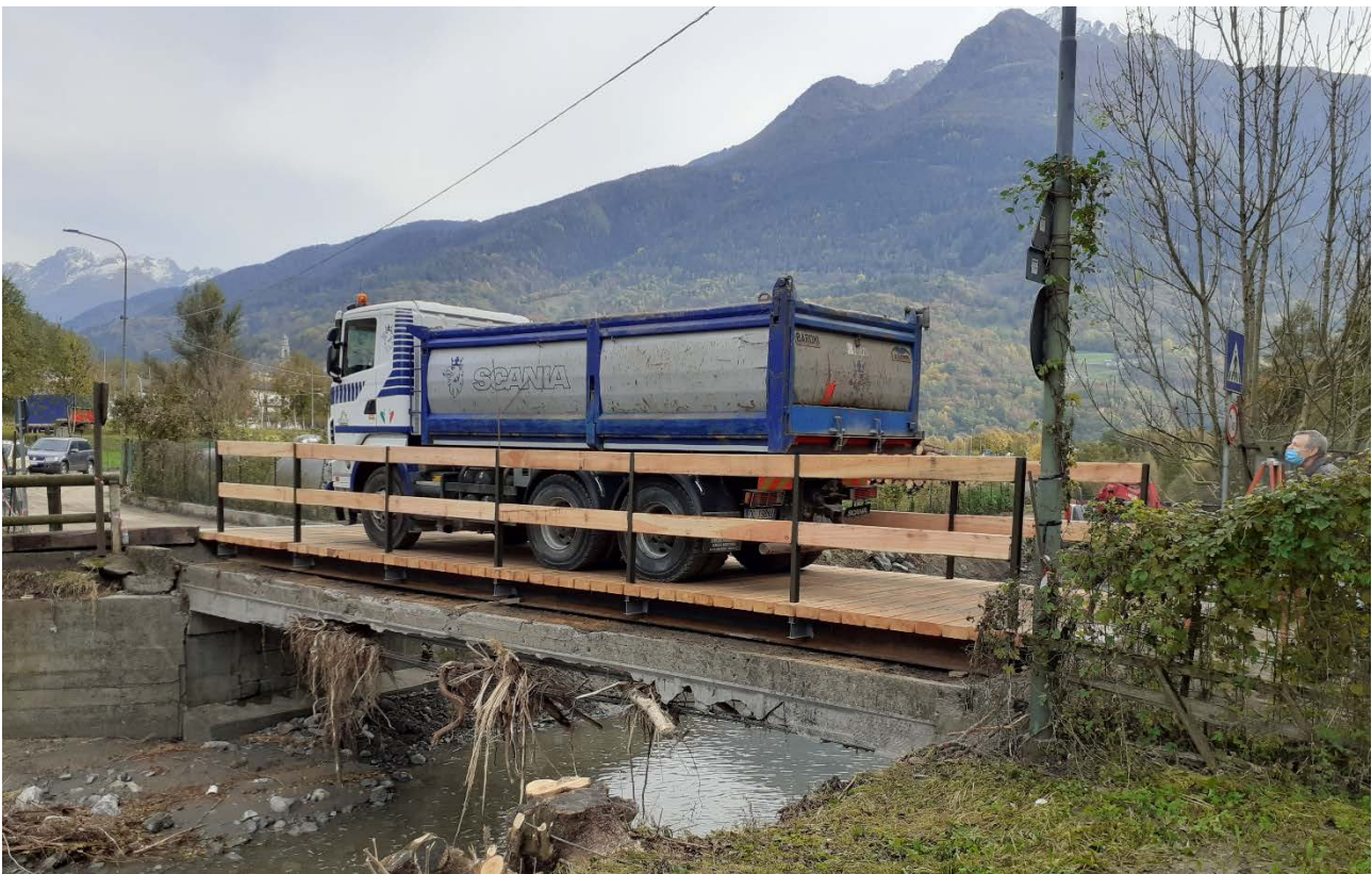
Figura 1: Ponte (da demolire) con questo progetto
