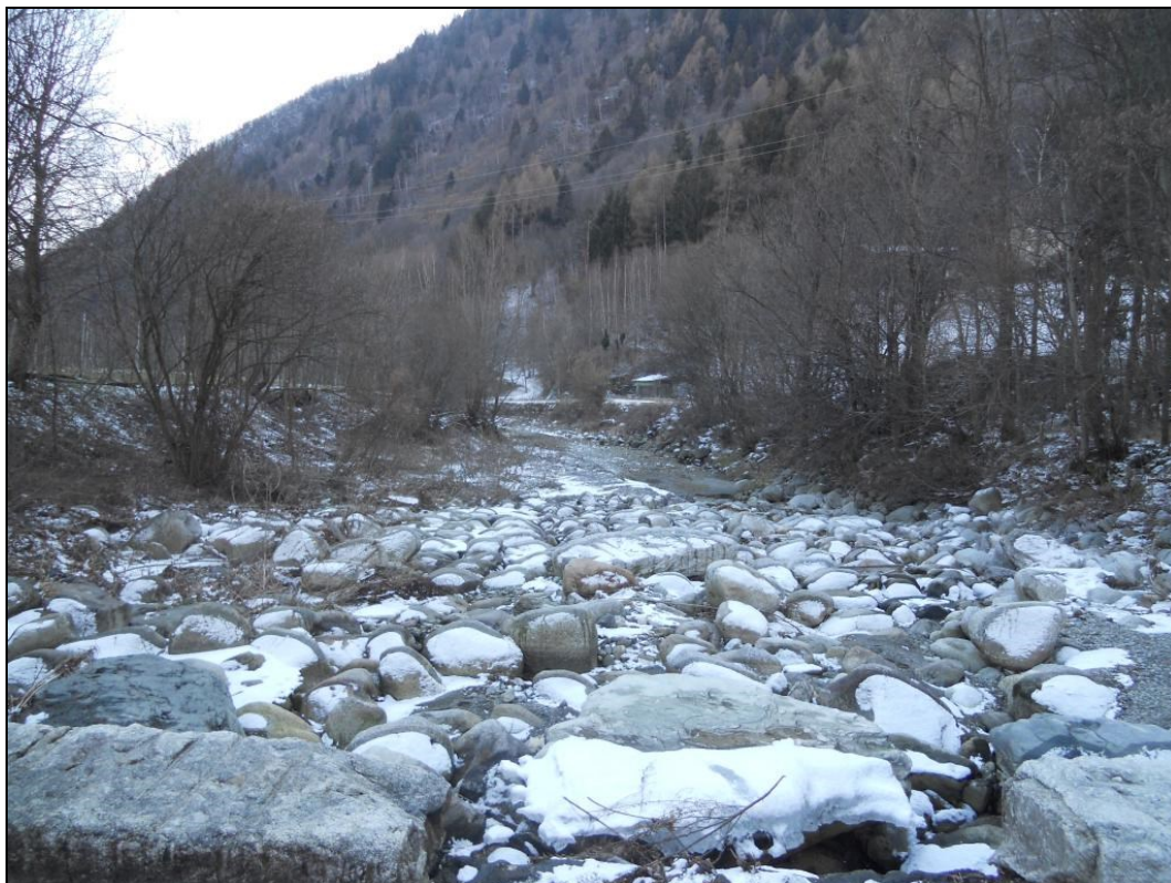
Materiale litoide depositato a valle della soglia (vista da monte)
