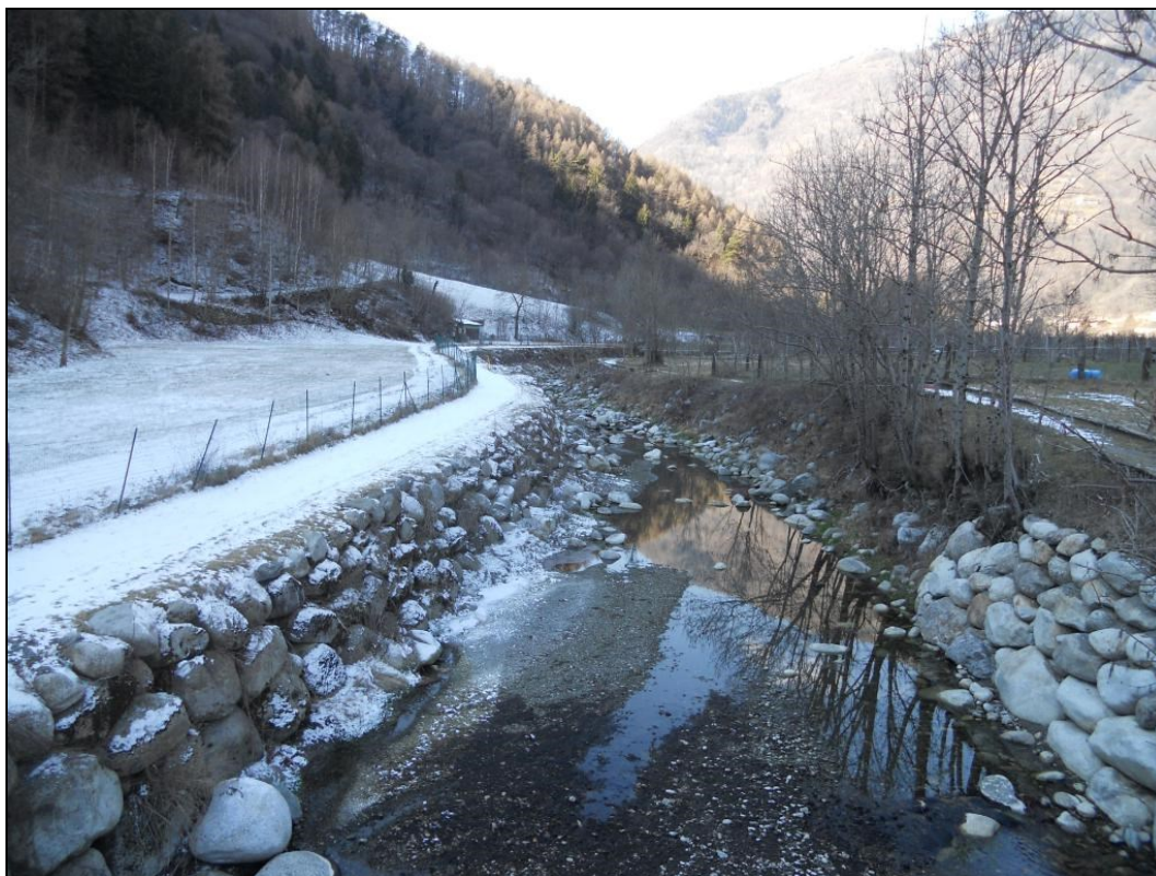
Vista da Ponte Località Fabiola
