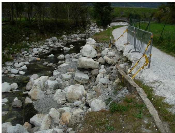
Foto n. 16 allegata al Progetto di Fattibilità Tecnica Economica
