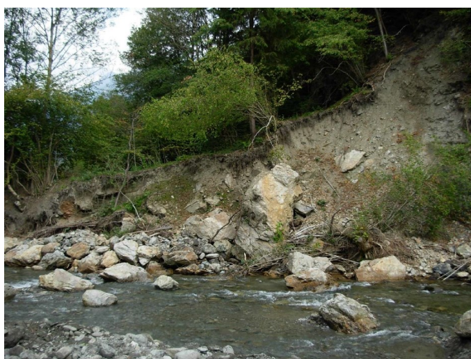
Foto n. 5 allegata al Progetto di Fattibilità Tecnica Economica
