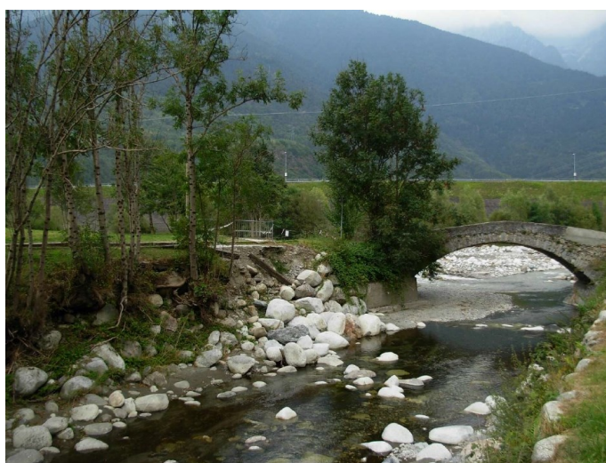
Foto n. 15 allegata al Progetto di Fattibilità Tecnica Economica
