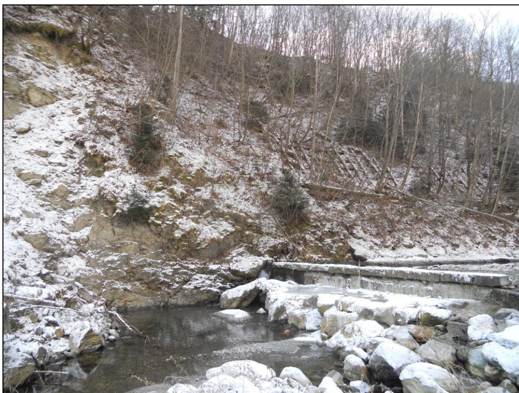
Vista frana in sponda destra
