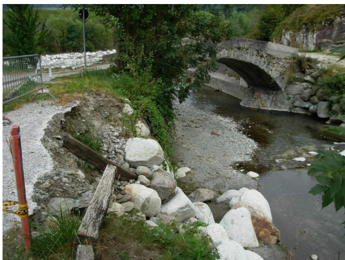
Foto n. 14 allegata al Progetto di Fattibilità Tecnica Economica
