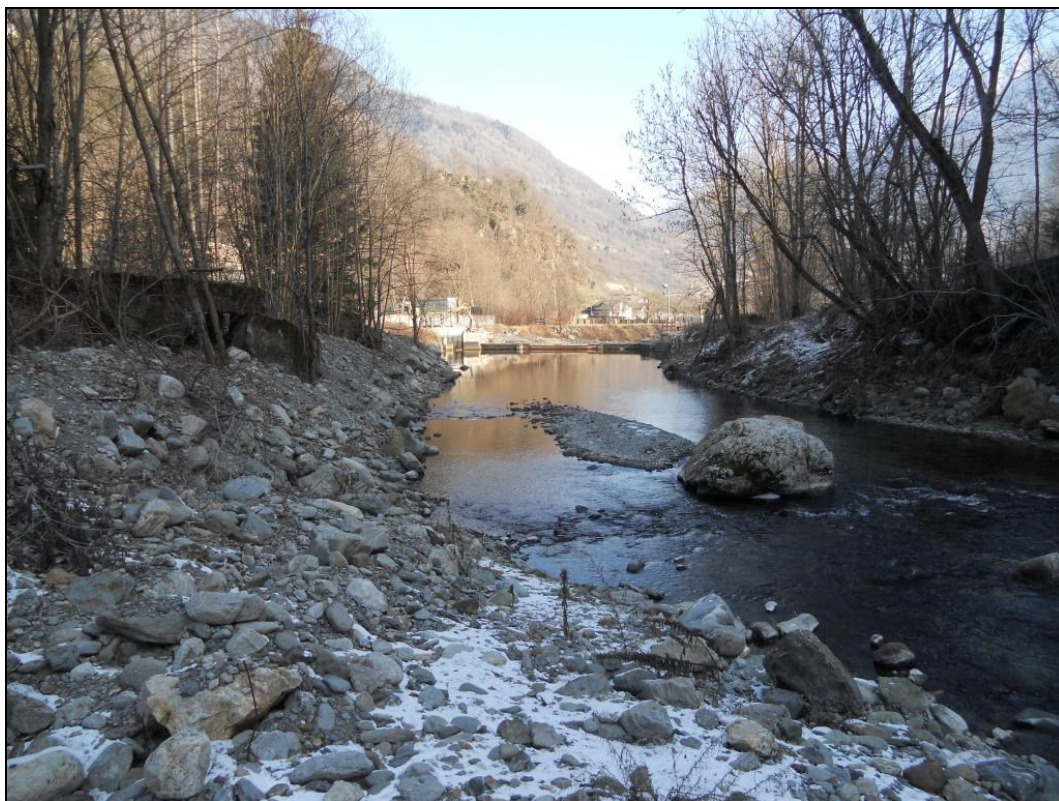
Vista opera di sbarramento centralina idroelettrica
