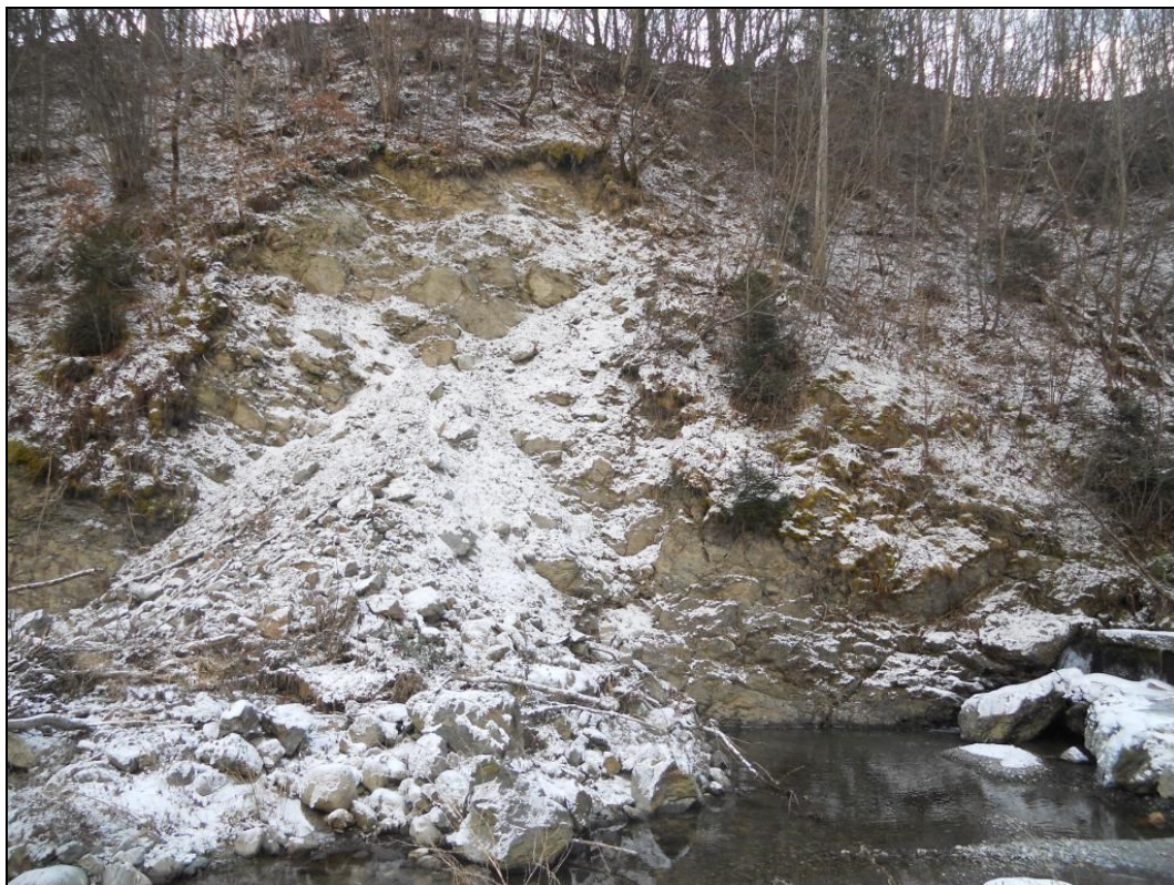
Vista frana in sponda destra
