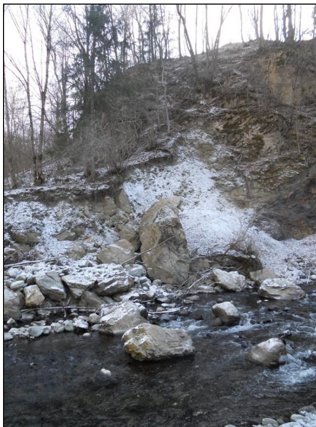
Vista frana in sponda destra
