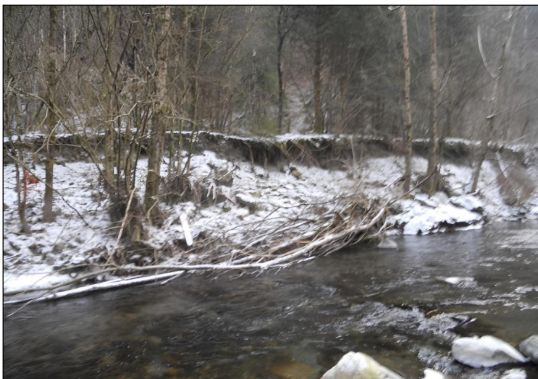
Scarpata erosa e scavernata in sponda destra
