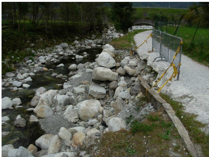
Foto n. 16 allegata al Progetto di Fattibilità Tecnica Economica
