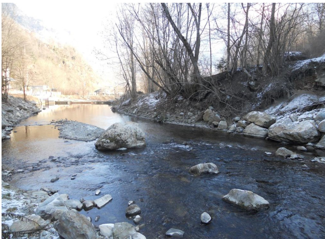
Scarpata erosa e scavernata in sponda destra con piante pericolanti sul ciglio
