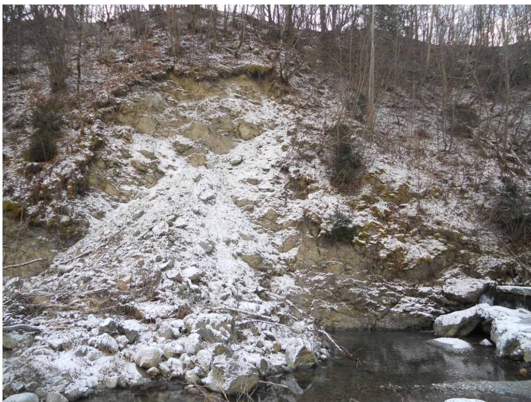
Vista frana in sponda destra
