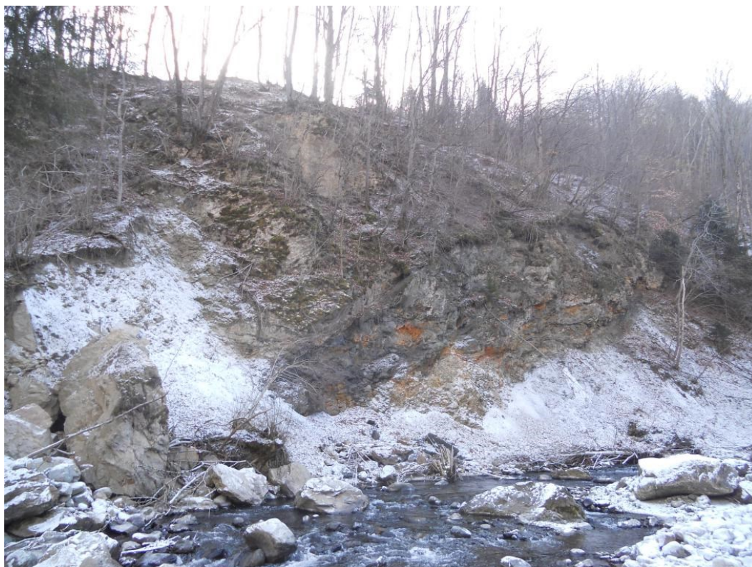
Vista frana in sponda destra
