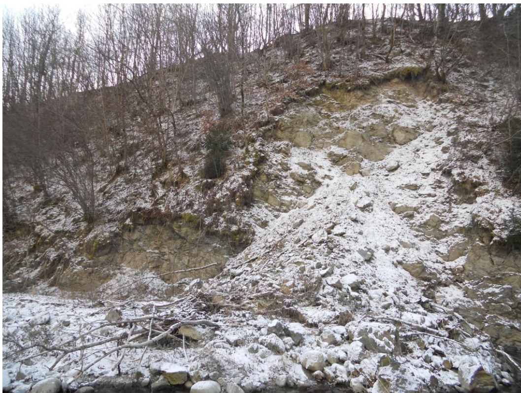
Vista frana in sponda destra
