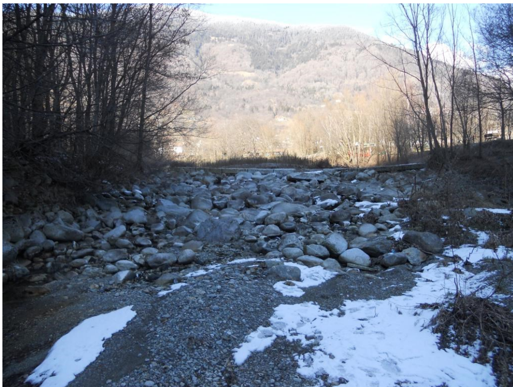
Materiale litoide depositato a valle della soglia (vista da valle)
