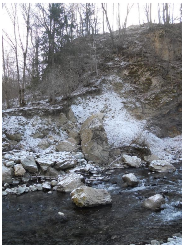
Vista frana in sponda destra
