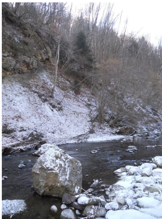
Vista frana in sponda destra
