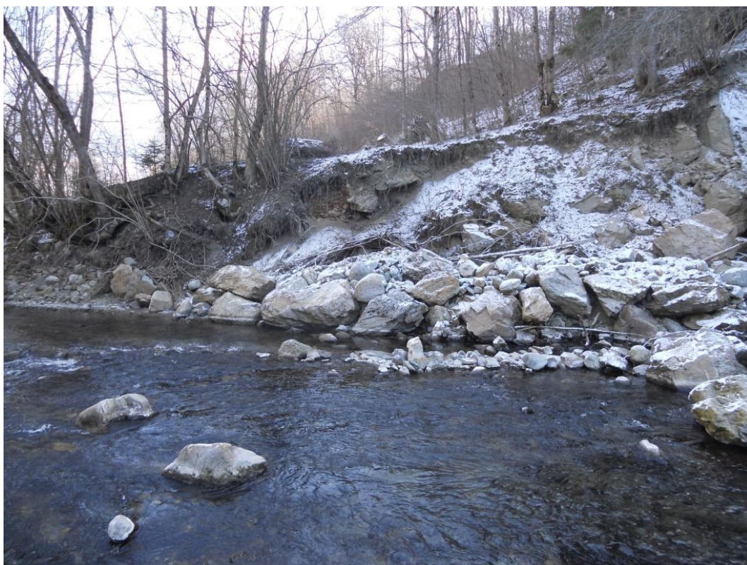
Scarpata erosa e scavernata in sponda destra con massi scivolati al piede
