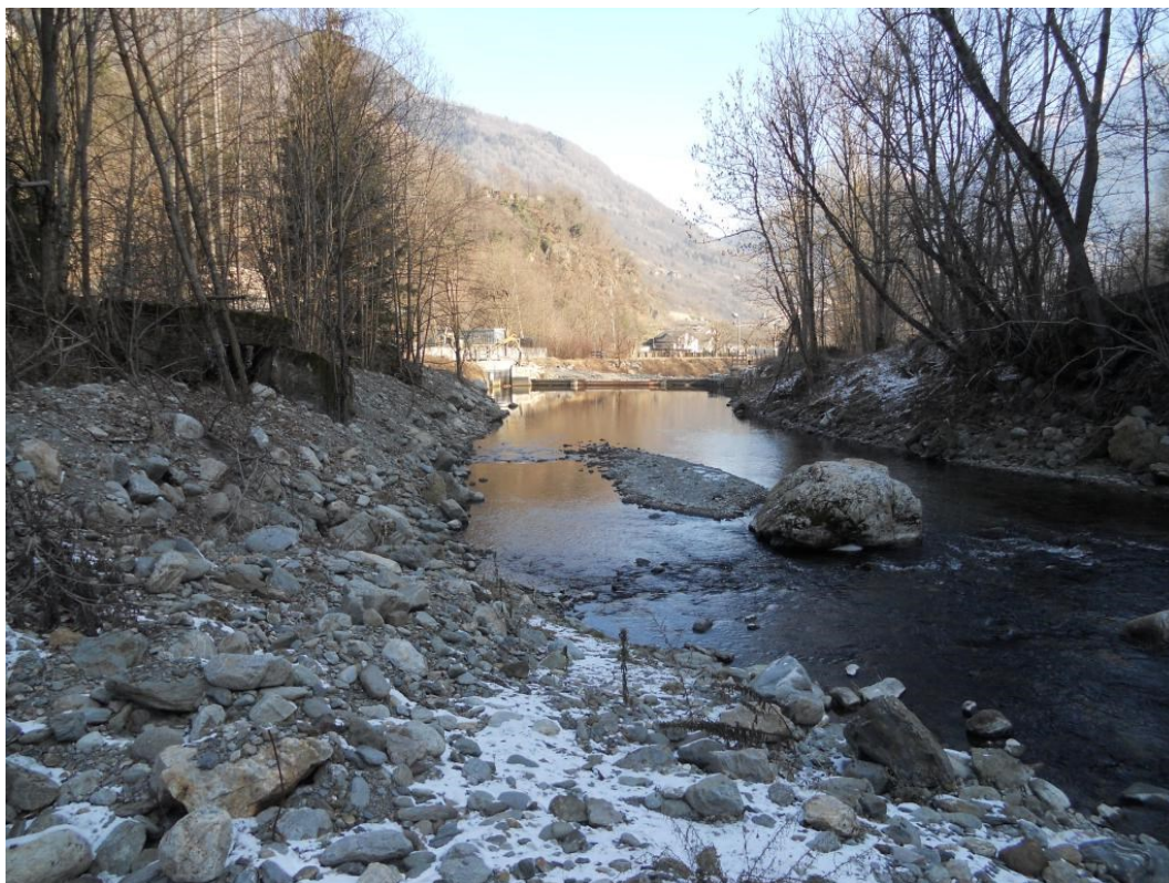
Vista opera di sbarramento centralina idroelettrica
