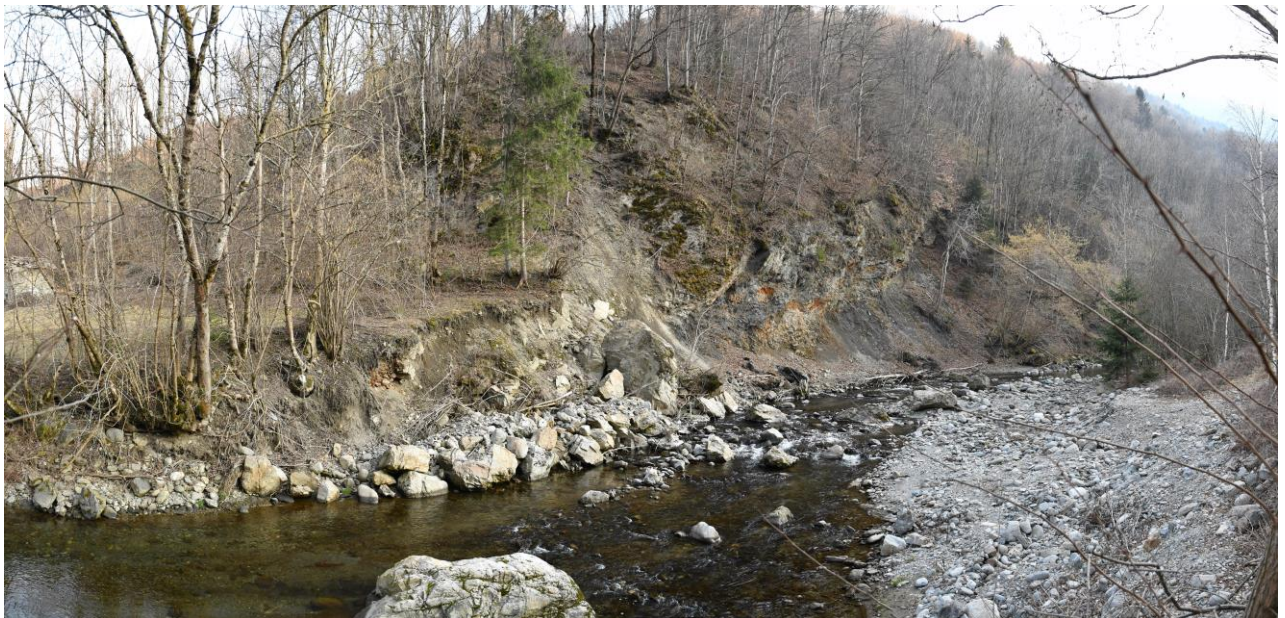
Figura 14: Settore in dissesto visto da valle
