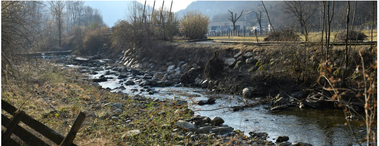
Figura 15: Soglia di fondo e manufatti idraulici presenti in sponda sx
