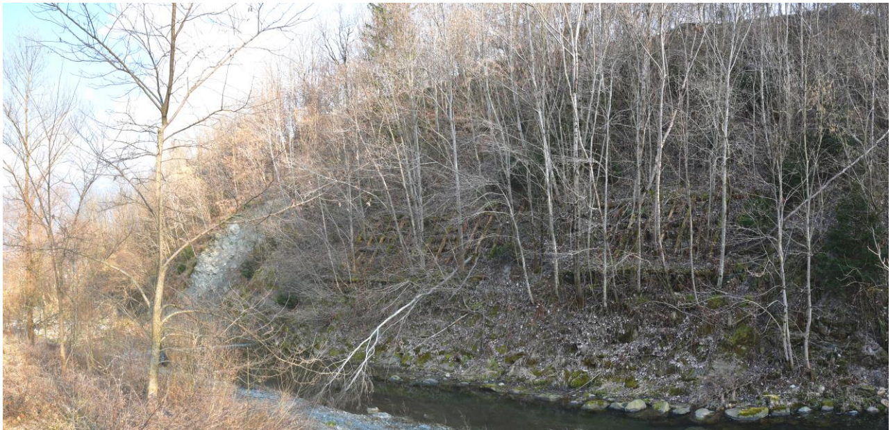
Figura 17: Pendice consolidata, soglia e nicchia di erosione viste da monte
