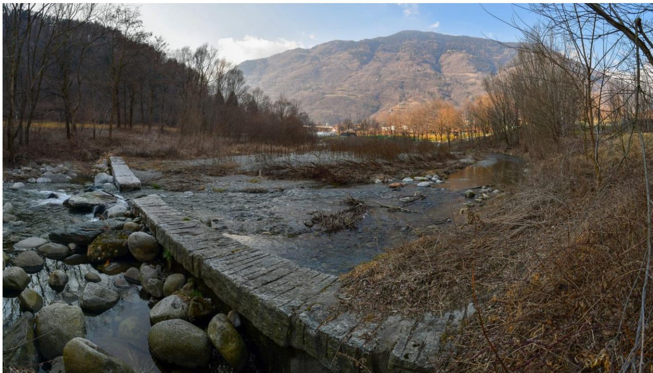
Figura 21: Soglia di fondo nei pressi del termine del termine ampliato da passate attività antropiche
