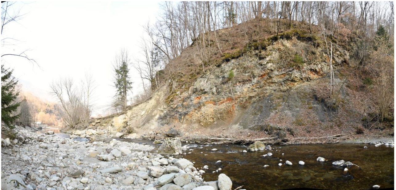
Figura 13: Settore in dissesto visto da monte
