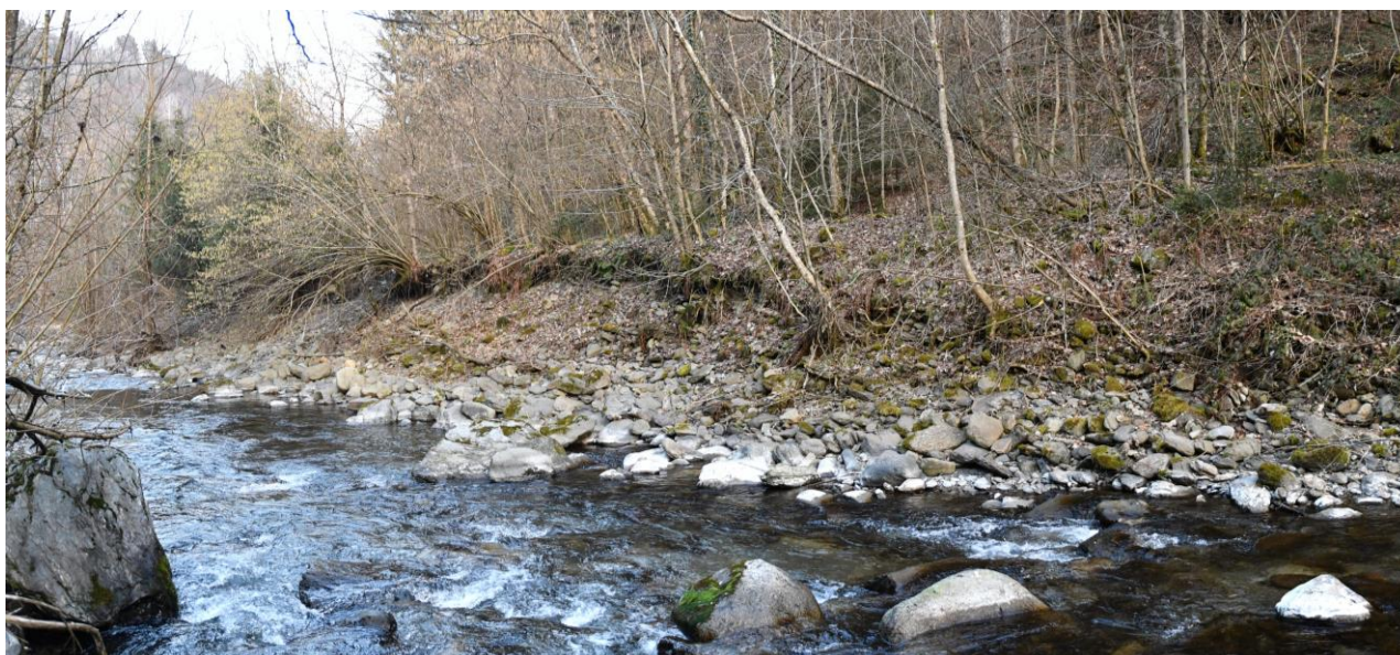
Figura 7: Fenomeno erosivo di quota 700 m visto da monte
