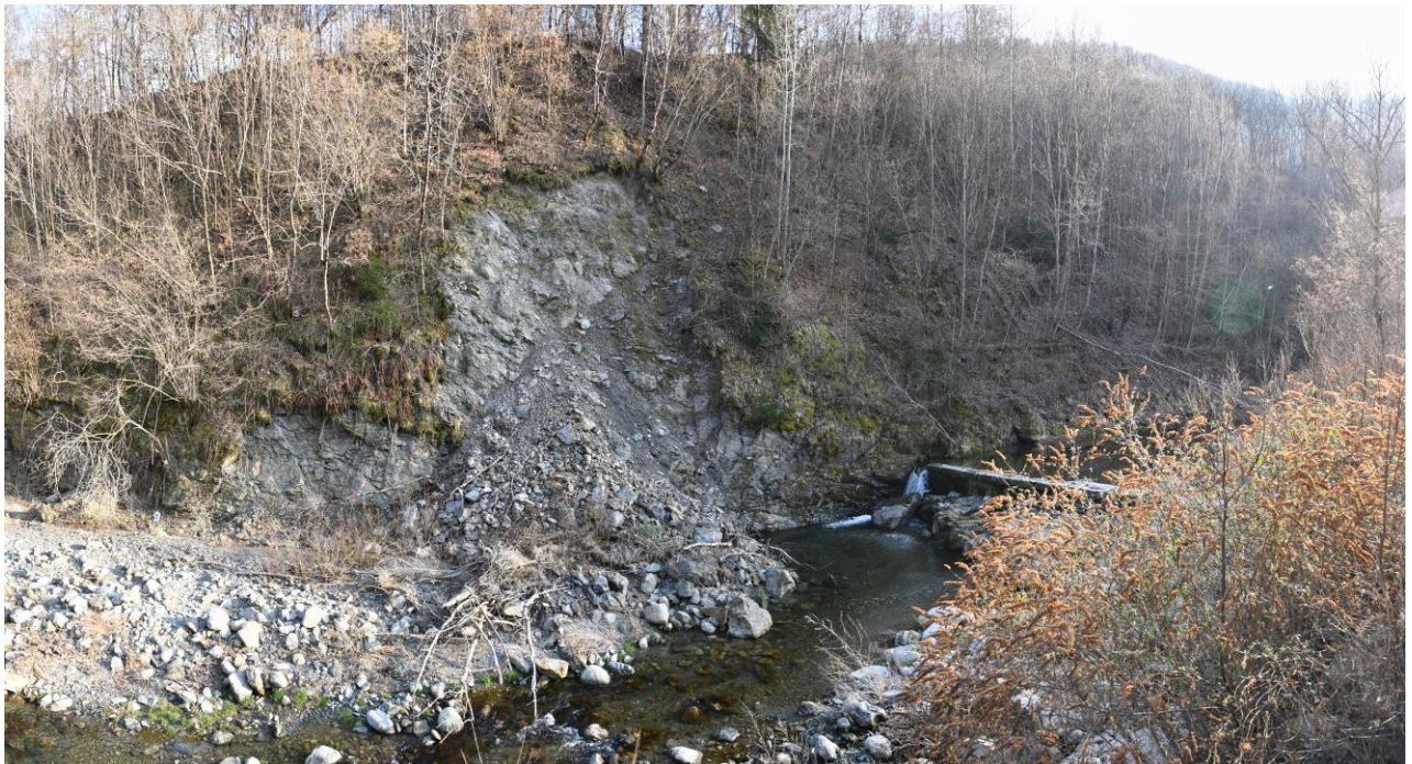
Figura 16: Fenomeno erosivo e pendice consolidata con grate vive, inframezzate dalla soglia di fondo
