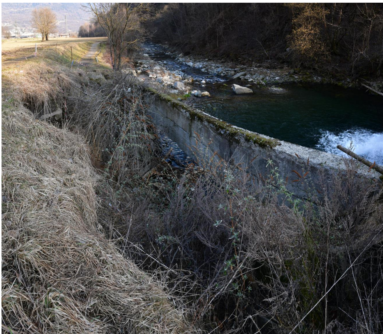
Figura 20: Muro arginale scalzato, “svuotato” e sospeso
