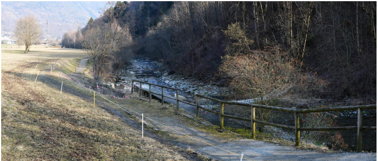
Figura 21: Percorso vita interrotto nel tratto franato
