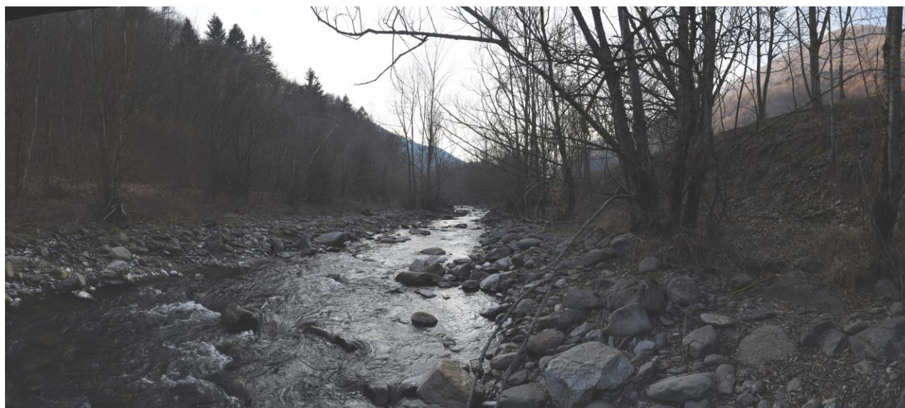
Figura 17: Alveo del torrente Ogliolo di Edolo a valle del Ponte Parnigò
