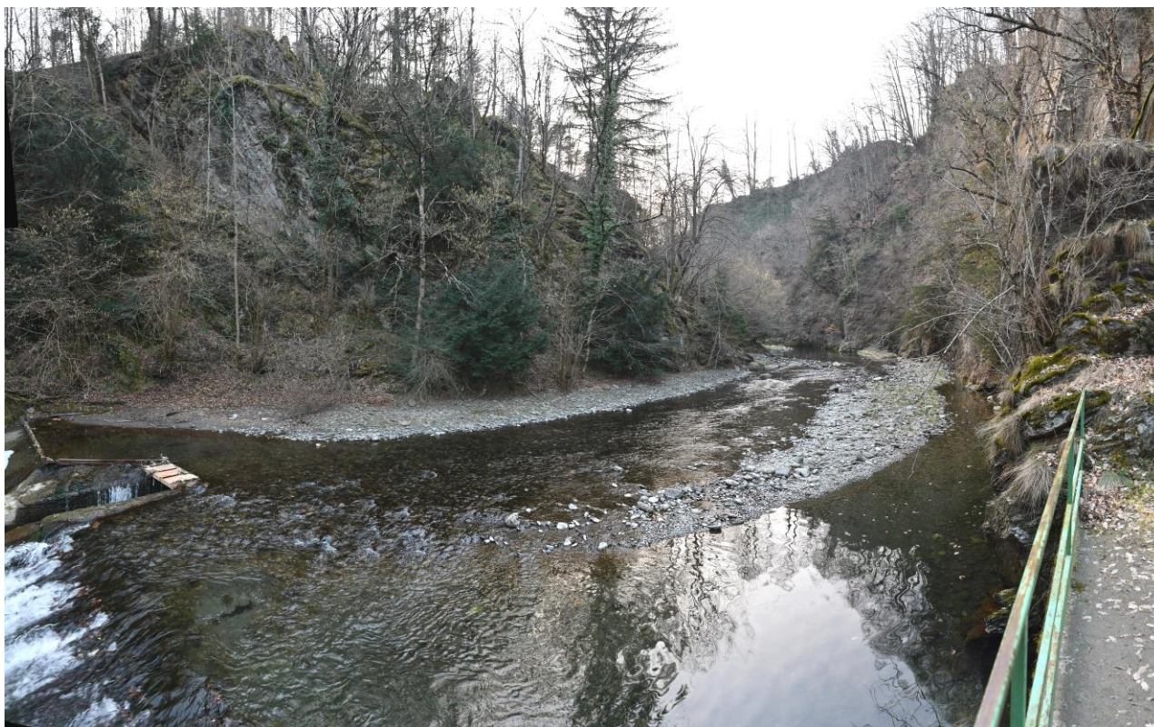
Figura 6: Settore a monte dell'opera di presa di quota 710 m slm
