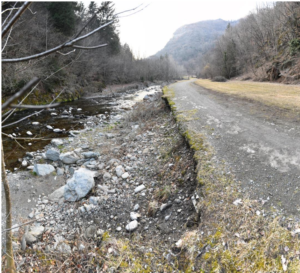
Figura 11: Fenomeno erosivo in sponda sx. Sul lato opposto in lontananza si nota la presenza di piante schiantate
