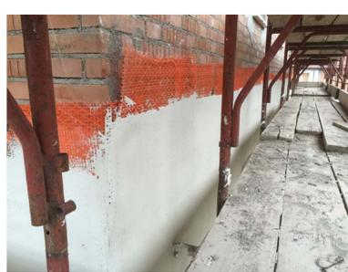
APPLICAZIONE DEL RINFORZO CON RASATURA TRASPIRANTE SULLE FACCIATE
