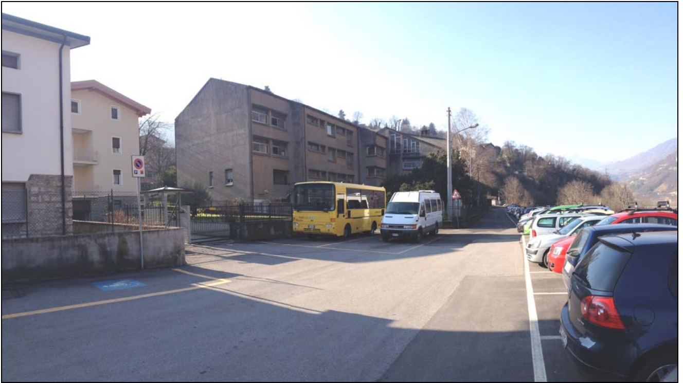
Foto -3- ripresa panoramica lato Nord/Est
