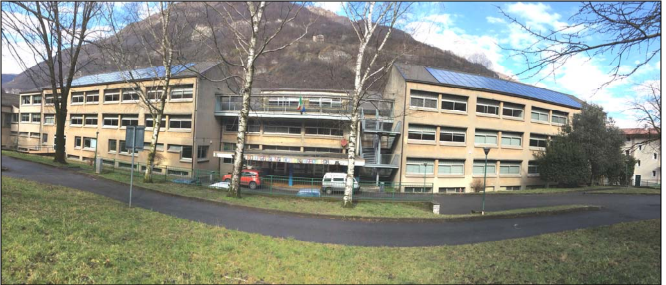
Foto -1- ripresa panoramica lato Sud/Est
